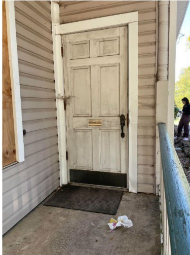
Fig: Existing Door
