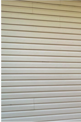
Fig: Existing Siding
